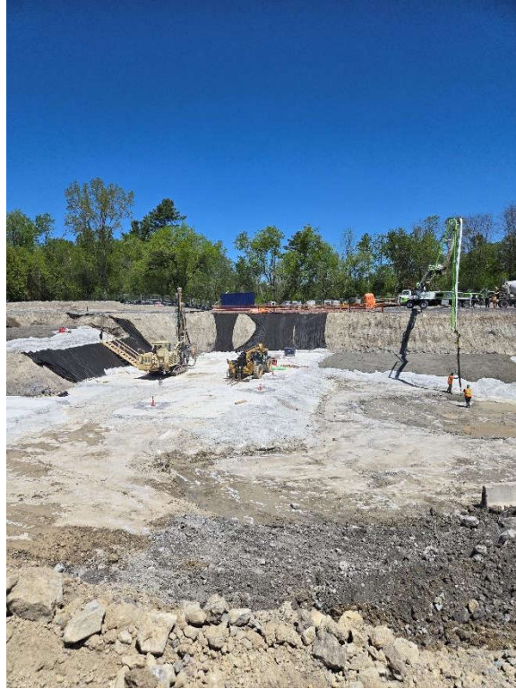
Photo 5: May 21 (mudslab pour for aeration tanks)
