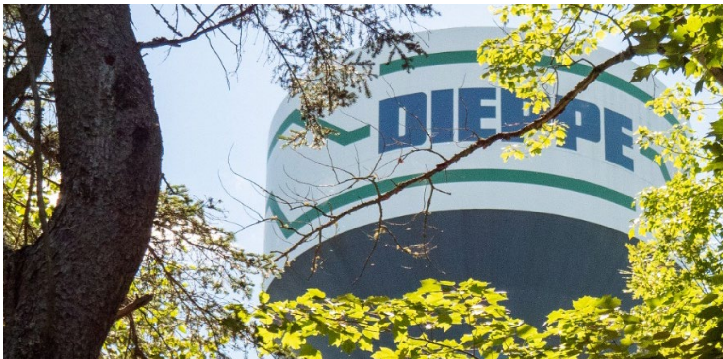
Figure 43: : Gros plan sur la tour d'eau de Dieppe.
