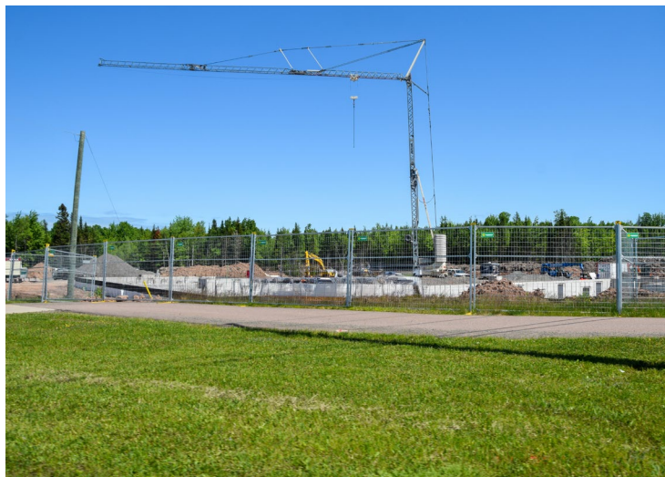
Figure 26: Travaux en cours le long du boulevard Dieppe
