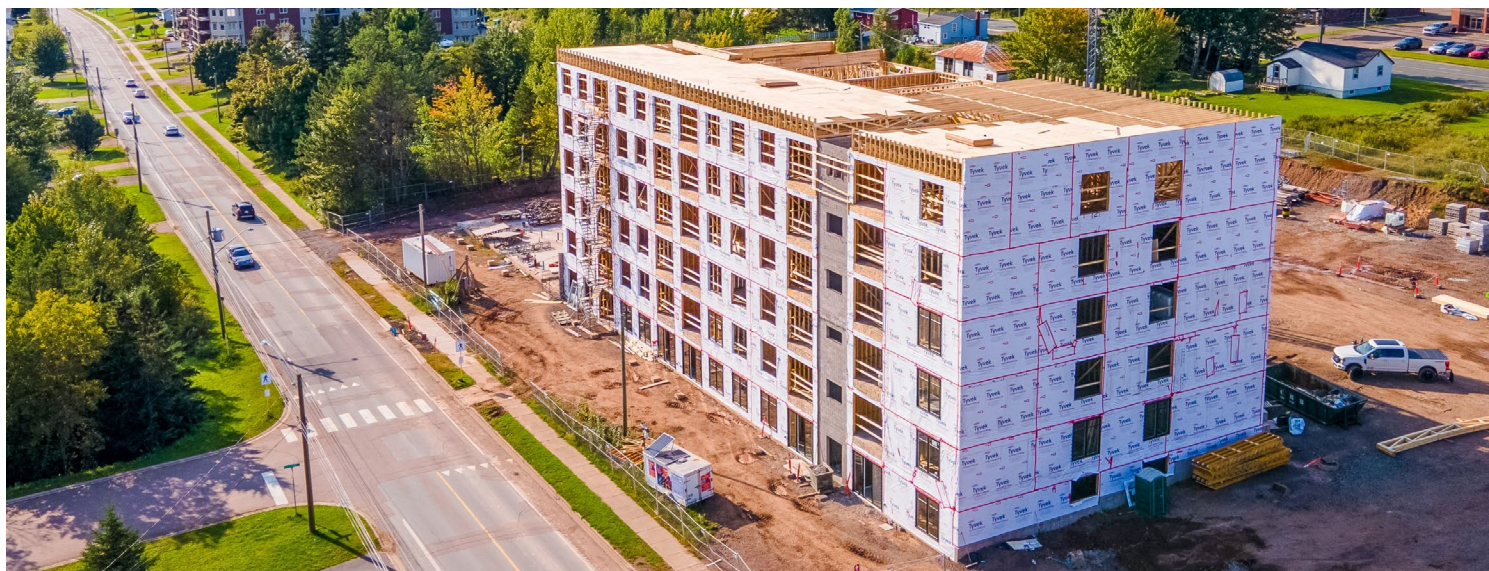
Figure 31: Construction d'appartements sur le chemin Gauvin.
