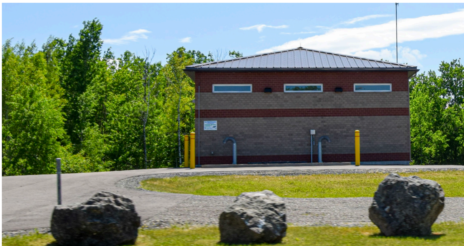
Figure 33: Station de pompage des eaux usées Fox Creek, rue Amirault
