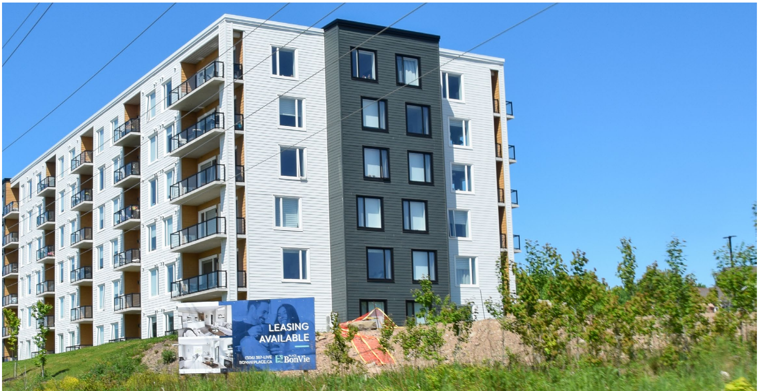
Figure 5: Immeuble multilogement récemment construit sur le boulevard Dieppe
