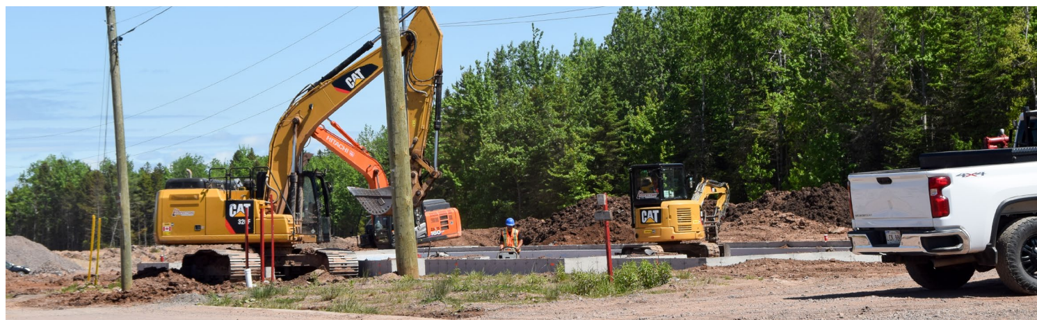
Figure 7: Construction d'une maison sur la rue Mélanie
