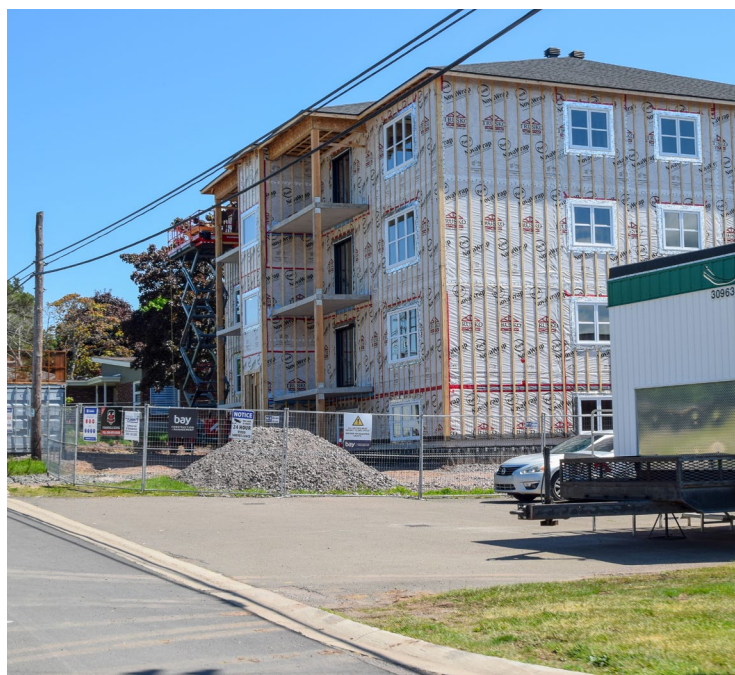
Figure 1: Chantier de construction sur la rue Amirault.
